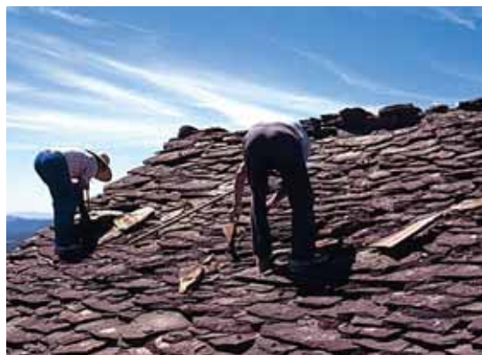
Reparaciones en un tejado de losa de Sobrarbe
