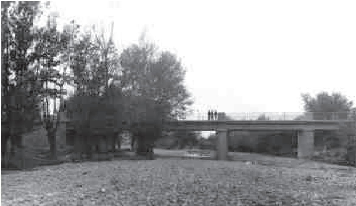
Azuara. Puente de hormigón sobre el río Cámaras (popularmente “río Aguas”). Actual carretera A-2306 (hacia 1930)
