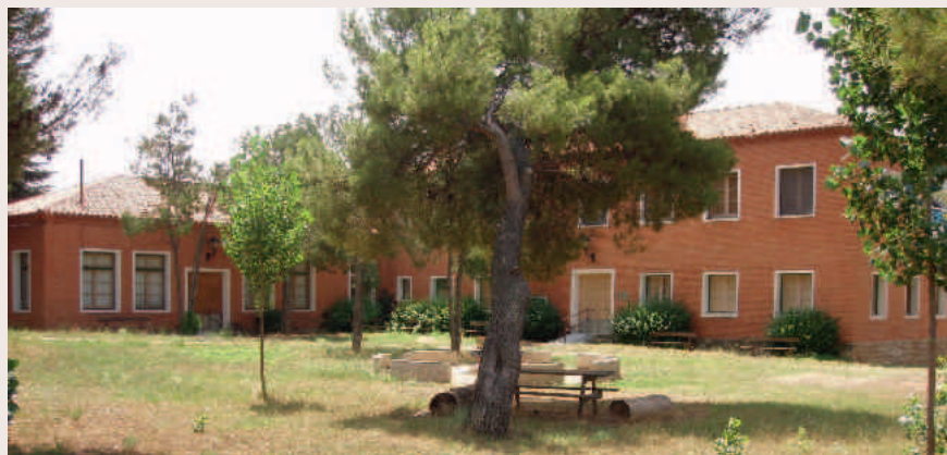
El centro de interpretación ocupa el antiguo edificio escolar de la empresa SAMCA
