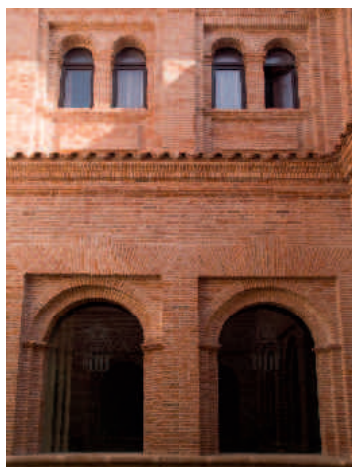
Vista actual del patio claustral restaurado
