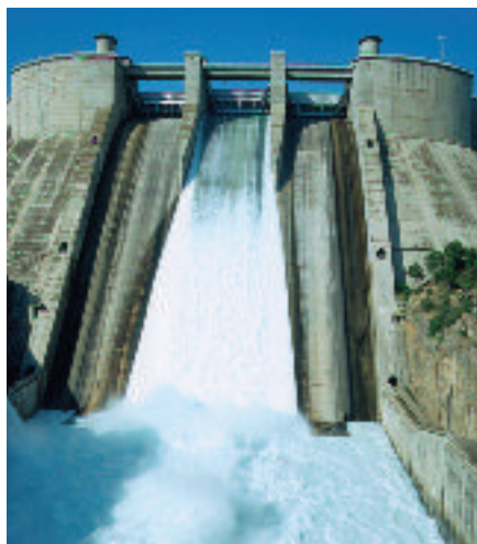
Presa de El Grado
