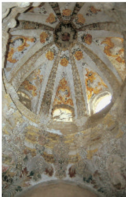
Capilla barroca en la parroquia de Yaso
