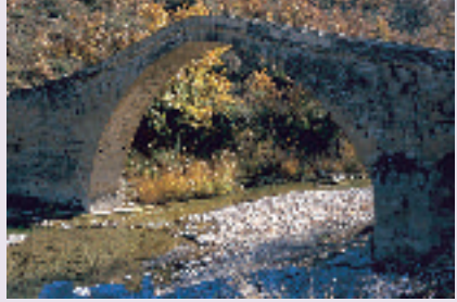
Puente de la Albarda, sobre el Vero
