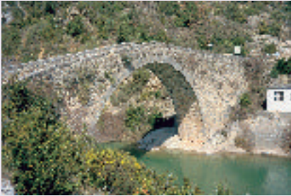
Puente de Pedruel, sobre el Alcanadre
