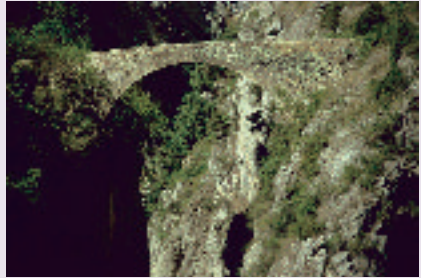
Puente de la Sierra (Olvena), sobre el Ésera
