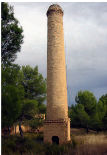
Estercuel. Chimenea de la antigua resinera
