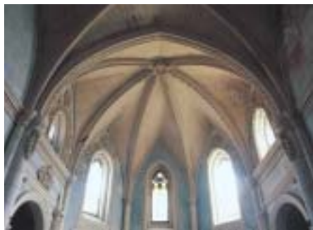
Interior de la iglesia de San Pedro Mártir de Torre del Compte
