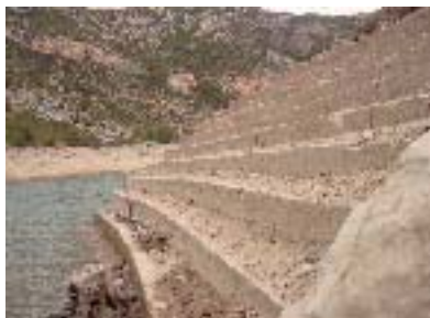
Calanda. Restos de la gran presa de Juan de Villanueva (1788)
