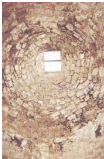
Cubierta de la nevera de La Cañada de Verich
