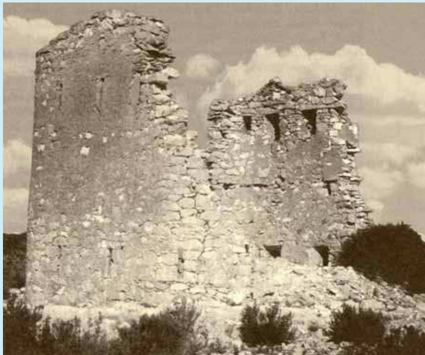
La Garita de Fayón antes de su derribo
