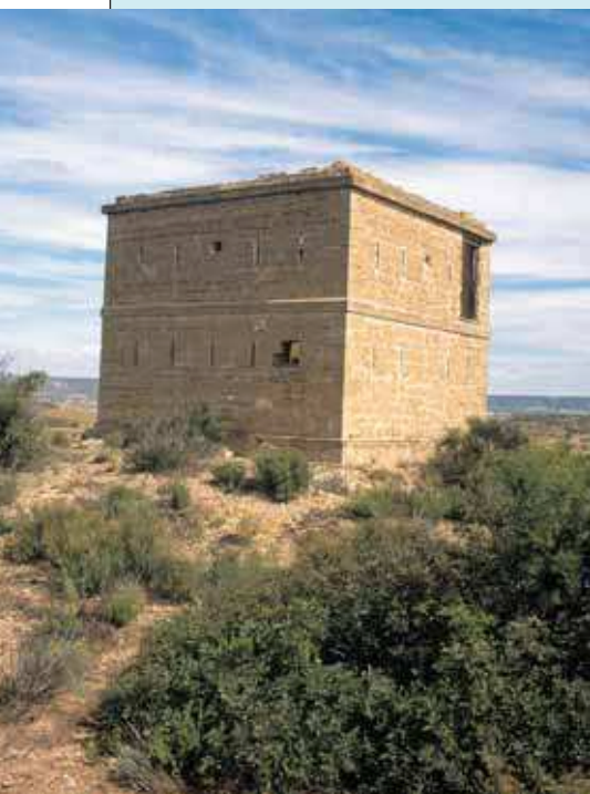
Torre óptica de Turlán en Caspe
